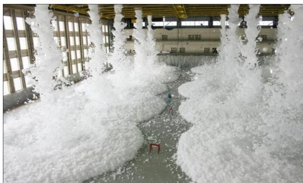
Рисунок 4 - Спринклерная установка пожаротушения
