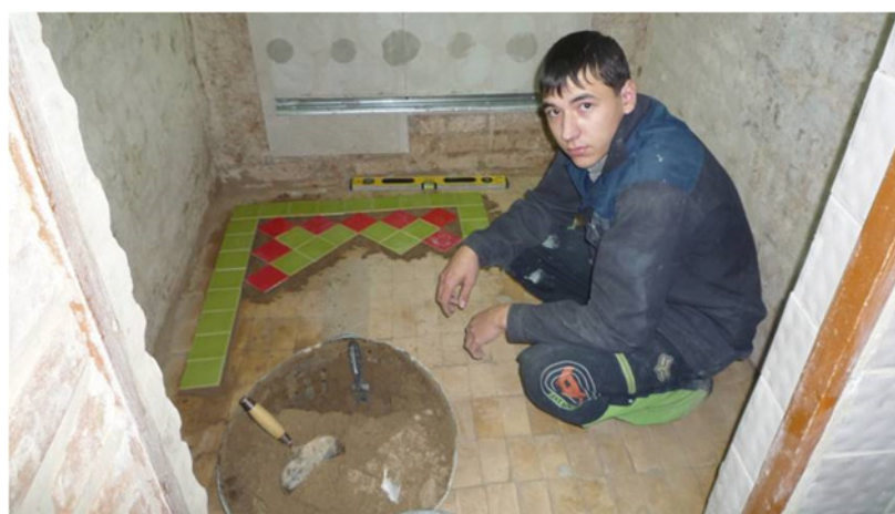
Фото1- Творческие работы по плиточным работам
