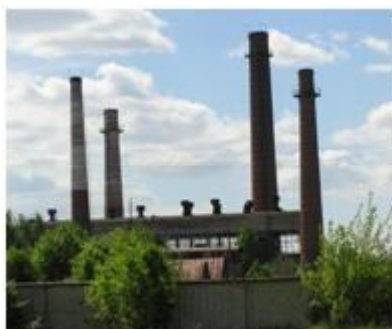
загрязнение атмосферного воздуха
