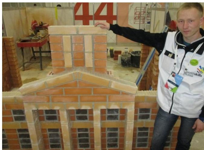
**Модуль 1 «Дворец в Архангельском»** Кладка выполняется из кирпича трех цветов. Расшивка шов в кладке в колоннах – плоская, в остальных швах – вогнутая. Толщина вертикальных и горизонтальных швов 10 мм. Длина модуля – 2200мм, высота модуля – 1500 мм.
