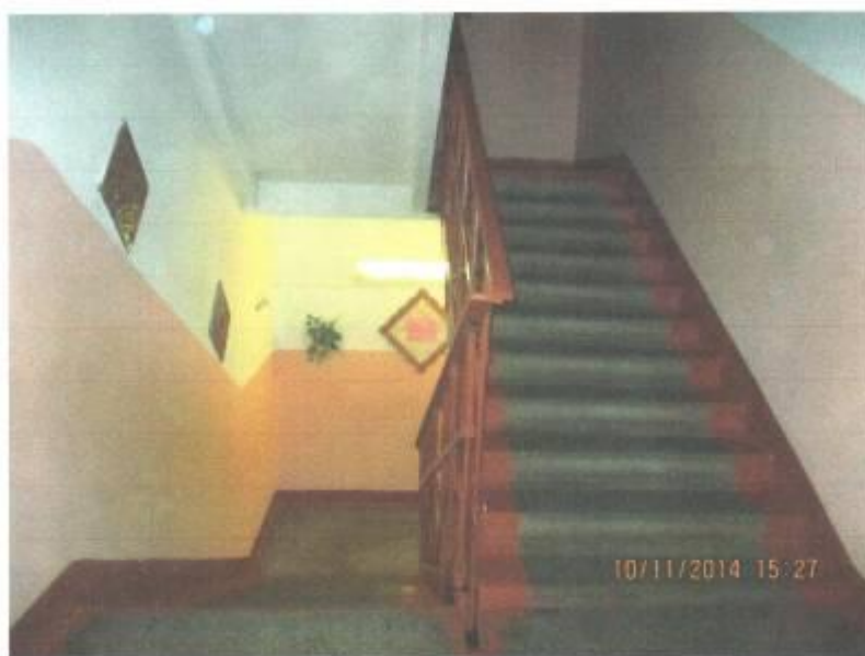
№ 10 Вид со 2 этажа: спуск на 1 и подъём на 3 этажи
