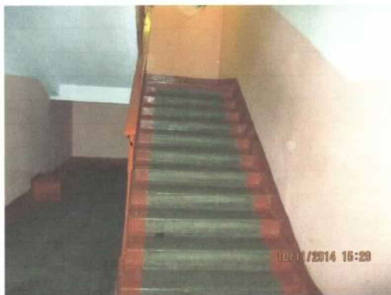
N 5 Подъём на 2 этаж
