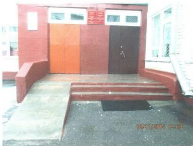
№ 2 Вход в школу
