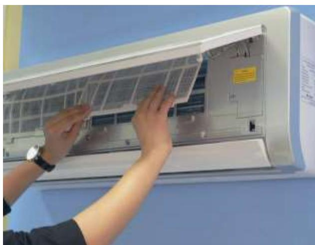
Комплексное обслуживание блока сплит-системы – более сложная операция, которую должны проводить квалифицированные специалисты. При комплексном обслуживании производится дезинфекция, чистится дренаж, чистится не только внутренний, но и внешний блок, производится дозаправка фреоном. Рекомендуемая периодичность в нашем регионе 1 раз в 2 года. Как правило - это платная услуга.
