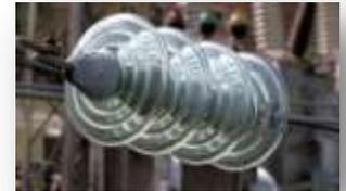
**НА ПОВЕРХНОСТИ ИЗОЛЯТОРОВ ЕСТЬ НАПРЯЖЕНИЕ.**
