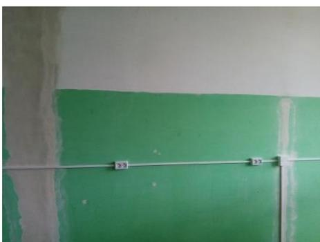
Проведение электросети к лабораторным столам в кабинетах химии и физики. Установка светильников
