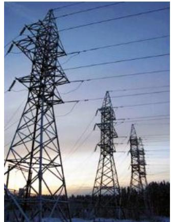
Так же как воду и газ передают по трубам, электрическую энергию передают на большие расстояния по кабелю под землей или по проводам над землей. Цепочка опор с натянутыми на них проводами называется линия электропередачи (или просто ЛЭП). Опоры бывают деревянные, бетонные или металлические. Все они очень высокие, и это не случайно: по проводам бежит очень сильное электричество, их размещают так, чтобы человек не мог случайно коснуться провода.
