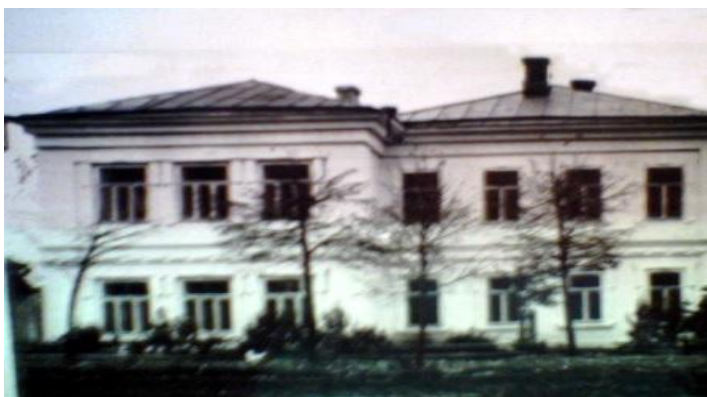
Здание Марийского научно-исследовательского института (1930).
